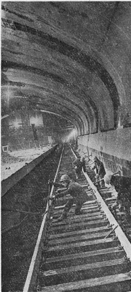
Укладка верхнего строения пути на станции «Институт культуры».
