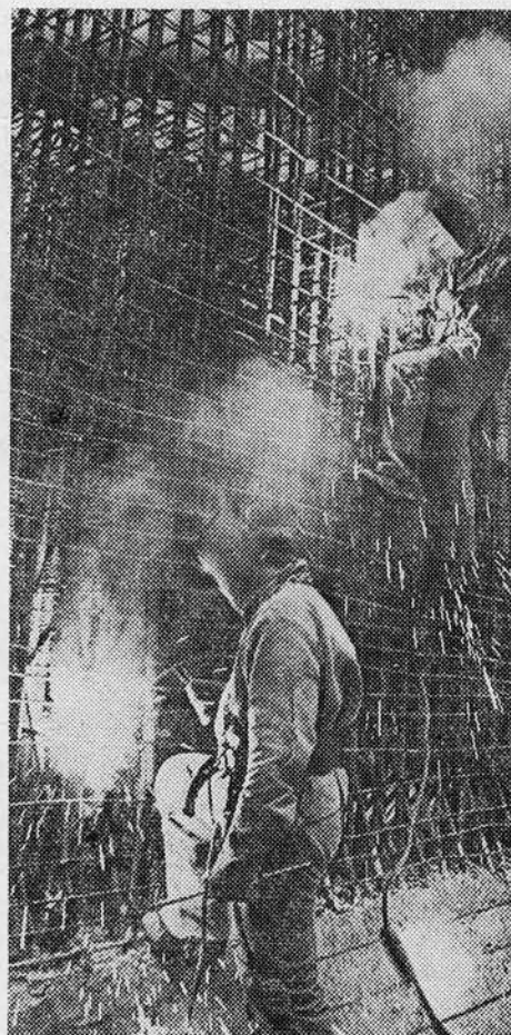
Монтаж и сварка арматурных каркасов и лотка на станции «Площадь Победы».
