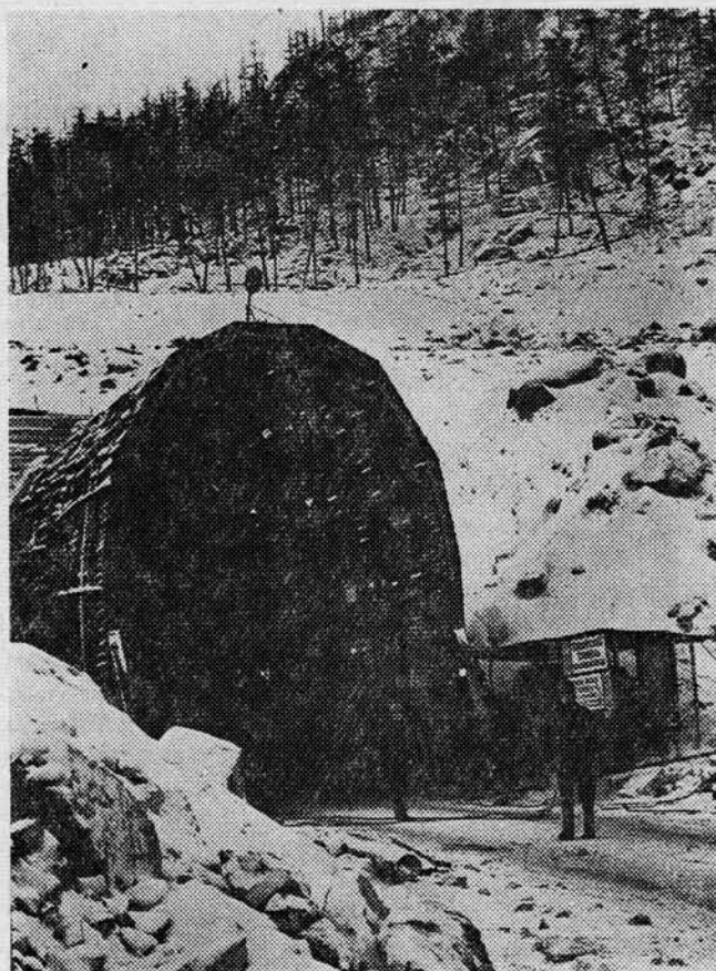
Врезка Кодарского туннеля.
