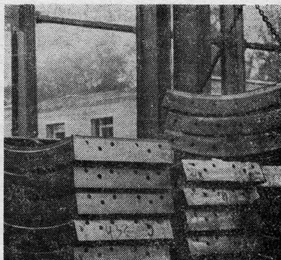
Тюбинги ДЗМО на площадке станции «Заводская»
