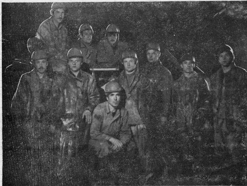
Комплексная бригада проходчиков Н. Никулина (третий справа) сооружает станцию «Дворец Ильича»
