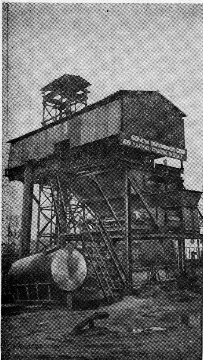
Горный комплекс на участке перегонного тоннеля «Пролетарская» — «Северная»
