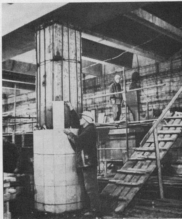
Отделочные работы на «Нагатинской»
