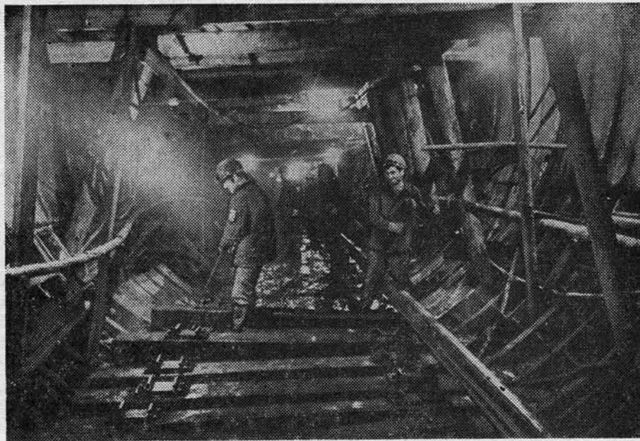
Укладка путей ТО-6.
