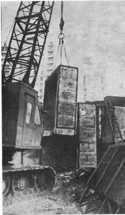
Фото 2. Монтаж секций с заводской гидроизоляцией на опытном участке.
