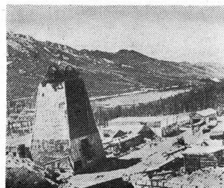
Фото 4. Второй ствол Северо-Муйского тоннеля.
