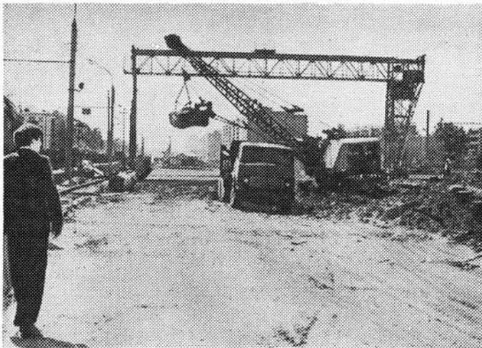
Выемка первых кубометров под котлован станции.
