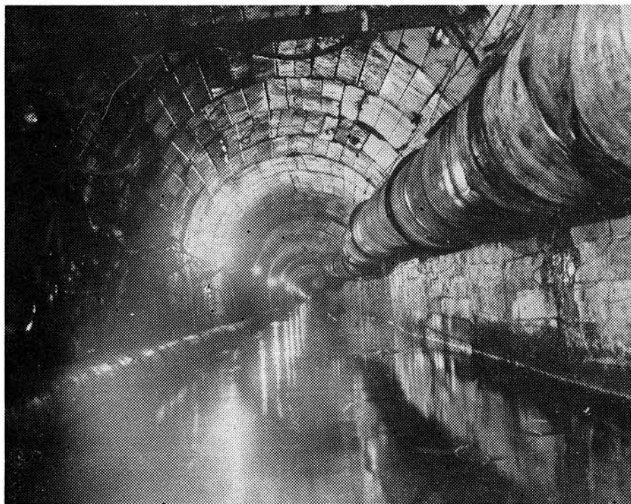
Рис. 2. Участок гидротехнического тоннеля Арпа — Севан.
