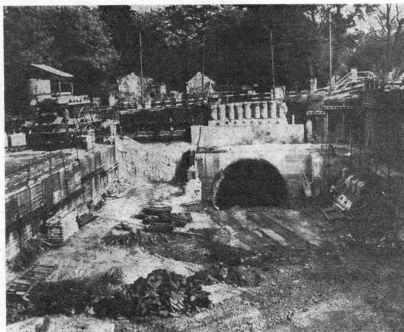
Возведение эскалаторного тоннеля станции «Флора» на линии ПА
