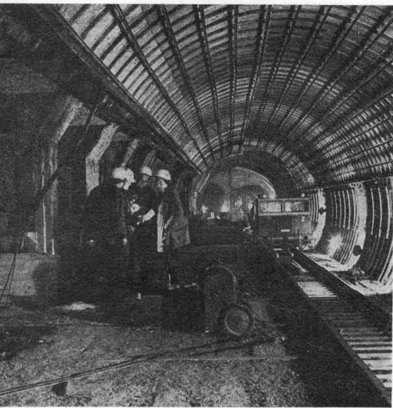
▲ Сооружение станционных тоннелей
