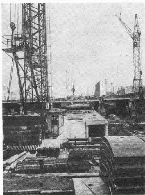
Строится станция «Дружба» на трассе ИС
