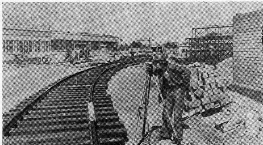
Путейские работы на площадке депо «Свиблово»
