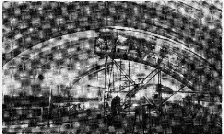
Отделка ст. «Бабушкинская»
