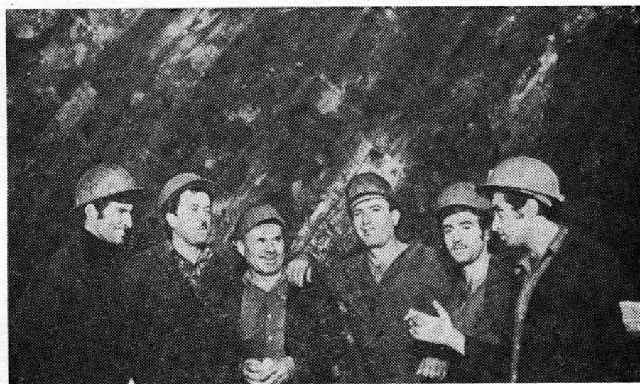
Строительство Мцхетского железнодорожного тоннеля. Бригада Ю. Сутидзе, работающая по методу Злобина, добилась скорости проходки 60 метров в месяц при сечении 63,3 м 2 , делая 111 шпуров длиной 2,5 м за смену. Бурильщики выполняют норму на 115—120%.
