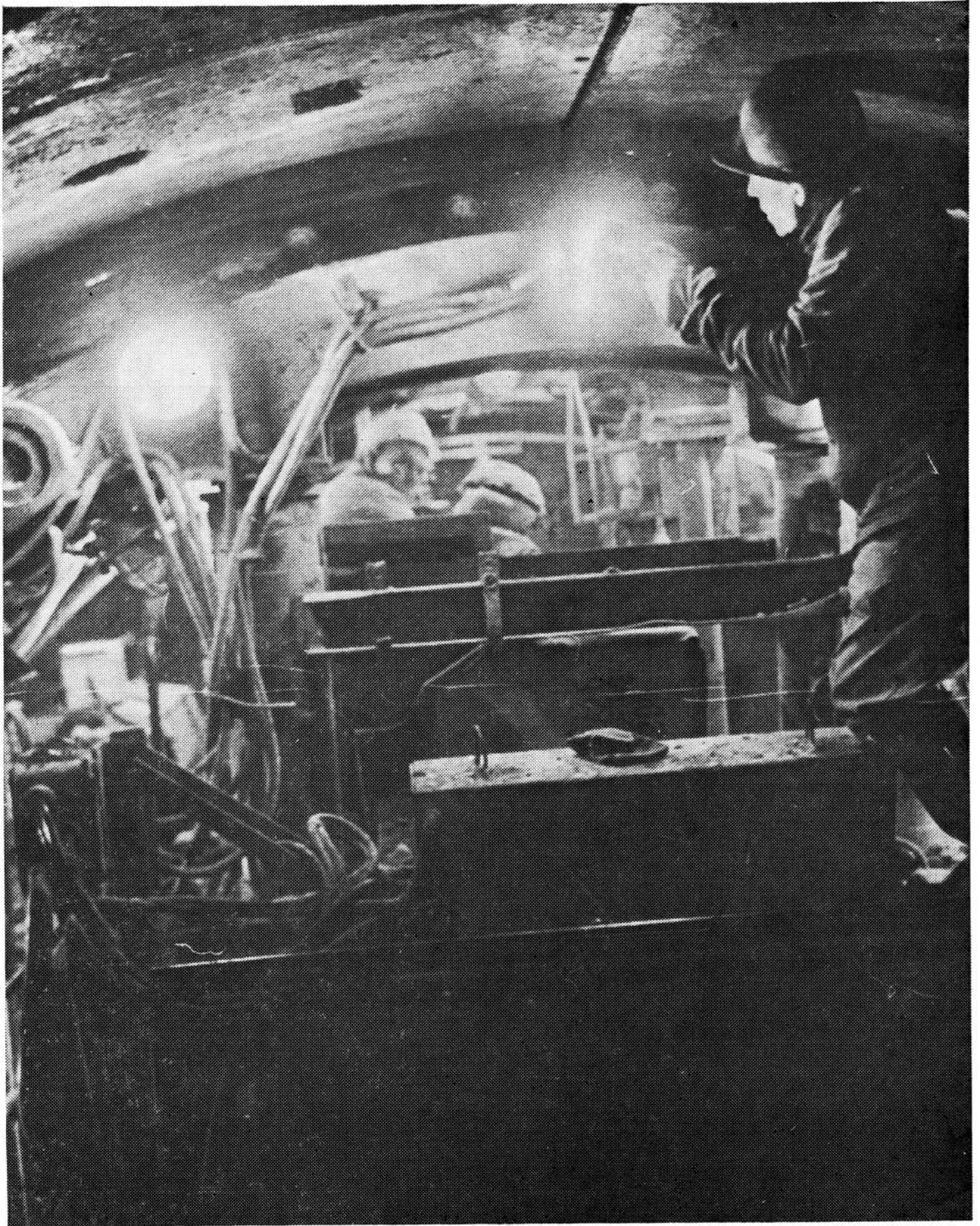
Проходка с помощью щитового комплекса КТ1-5,6 с дугвым конвейерным укладчиком
