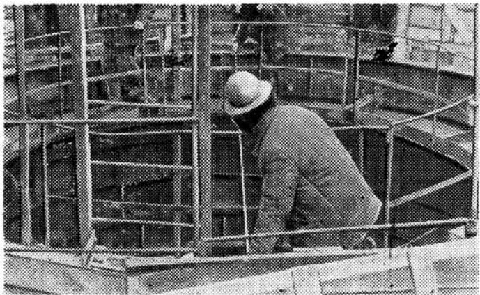
Металлический полон форшахты, с которой производится монтаж тубинговых колец (СМУ-5)
