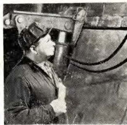
Расклатив блонны правой стороны тоннеля для установки клиновых финсаторов.
