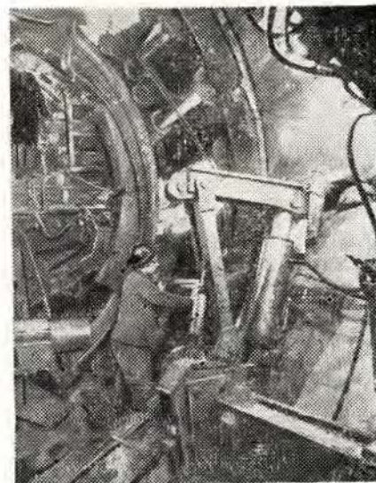
Расжатие блоков тоннельной обделки для установки клиновых финсаторов.
