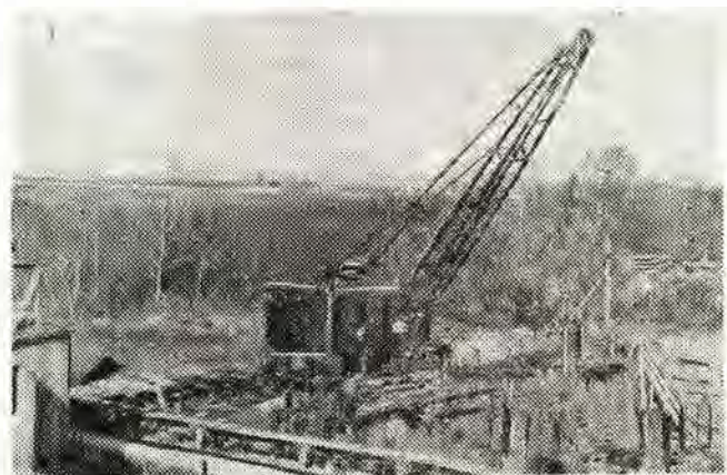
Разработка грунта в щитовой намере. Его выдают с помощью крана.
