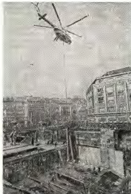
Станцию «Национальный музей» в Праге помогал строить вертолет. С его помощью опускались двенадцатиметровые опорные столбы под перекрытие.
