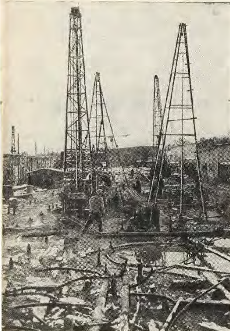
Для замораживания огромного участка размыва на строящейся Кировско-Выборгской линии нужно пробурить 350 километров скважин.
