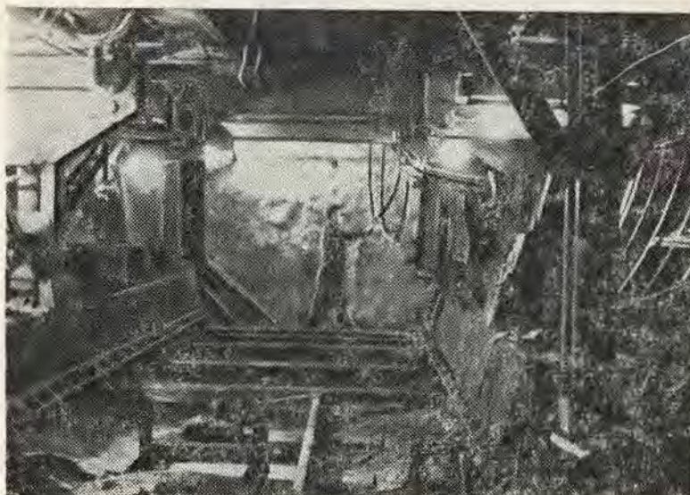
Проходка щитом перегонного тоннеля в районе размыва.
