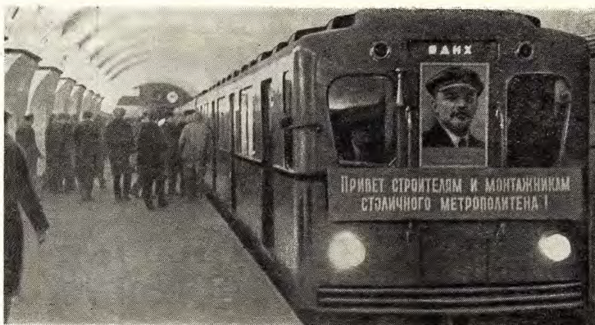
Первый поезд на новой станции.
