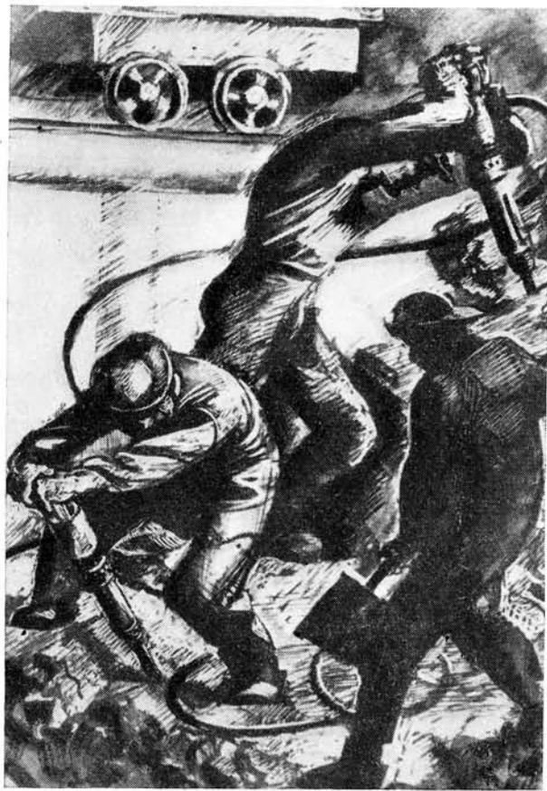
На сооружении тоннелей в основном применялся горный способ проходки с возведением монолитной обделки. Для временной крепи использовался лесоматериал. Установка крепи выполнялась вручную. Породу разрабатывали отбойными и бурильными молотками, кайлами, кирками, лопатами.
