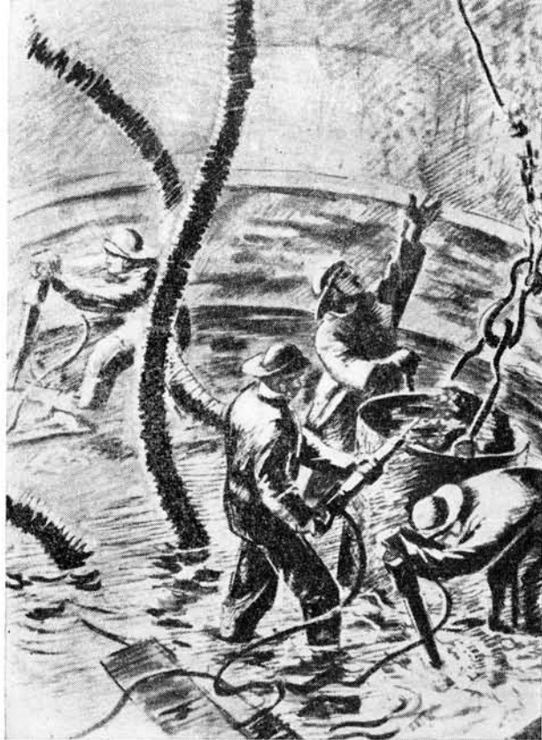
Проходка стволов на первой очереди: выдача породы в бадах емкостью до 0,5 м 3 при помощи кран-укосин. Погрузка породы в бады лопатами.
