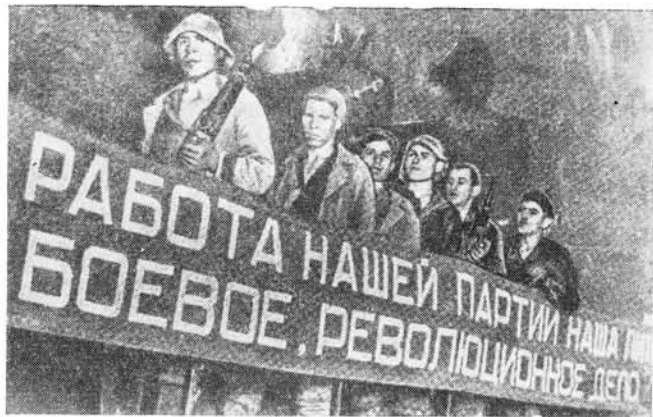
На первой очереди молодежь, комсомольцы вели проходку под сжатым воздухом в сложных гидрогеологических условиях. На снимке: бригада проходчиков-кессонщиков после смены.
