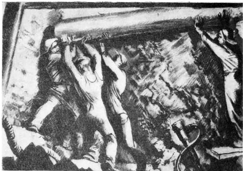
В 1933—1935 гг. при проходке штолен устанавливали временную деревянную крепь (дверные оклады). На рисунке изображен момент установки верхняка.
