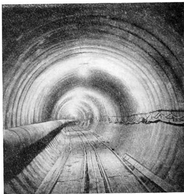
Рис. 4. Общий вид тоннеля.
