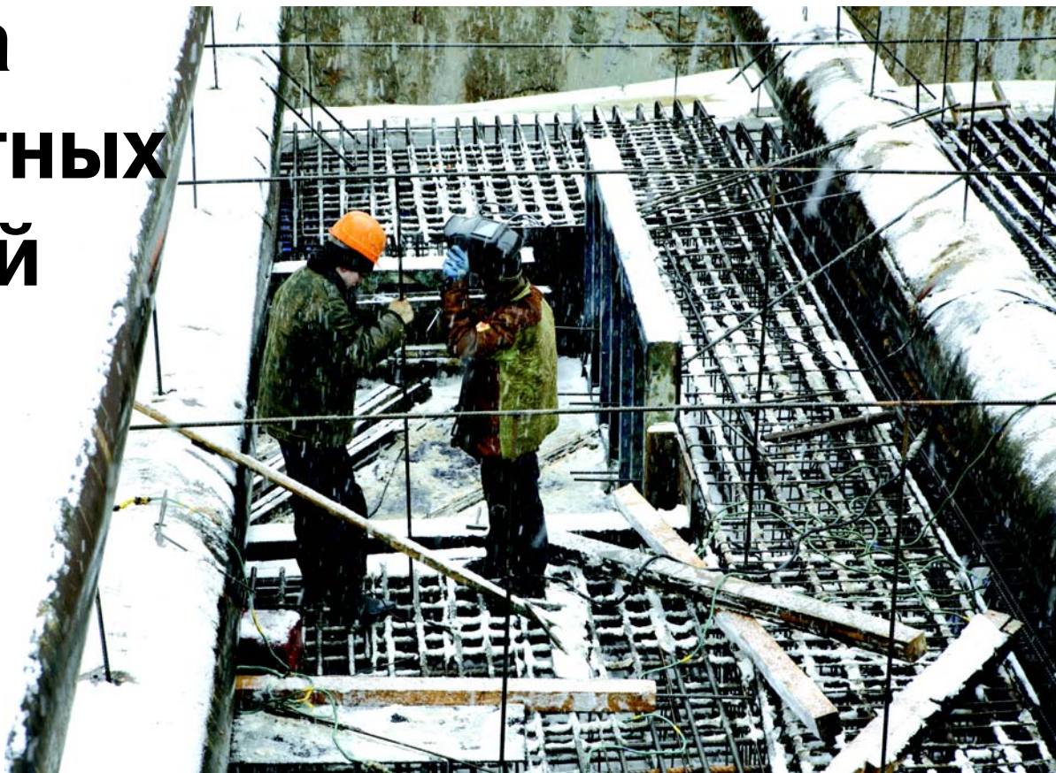
Армируется перекрытие тупиков.
