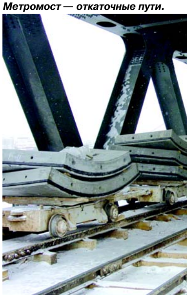
Метромост — откаточные пути.
