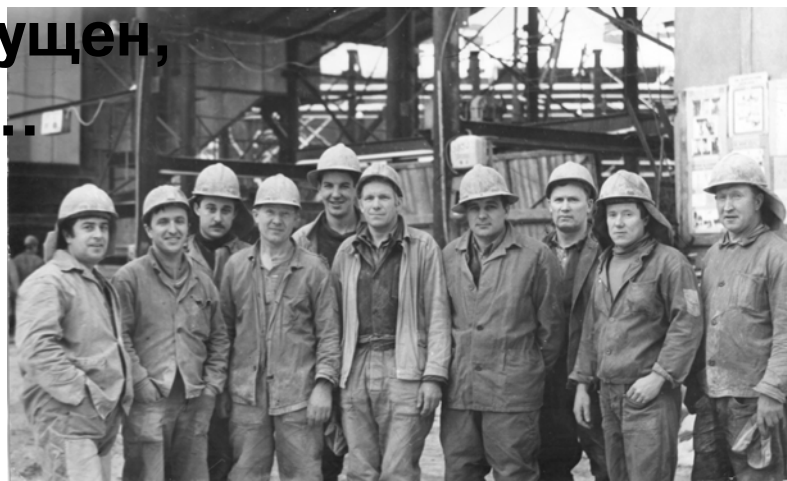
Бригада проходчиков Алексея Дмитриевича Лизунова на станции «Нахимовский проспект». Бригадир — четвертый слева.
