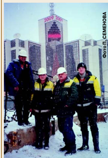
На строительстве наклонного хода и вестибюля станции «Сретенский бульвар». Слева направо — начальник участка О.И. Лещенко, механик Р.В. Приймич, зам. начальника участка В.Н. Кузьмин, проходчик Е.Ю. Баев.
