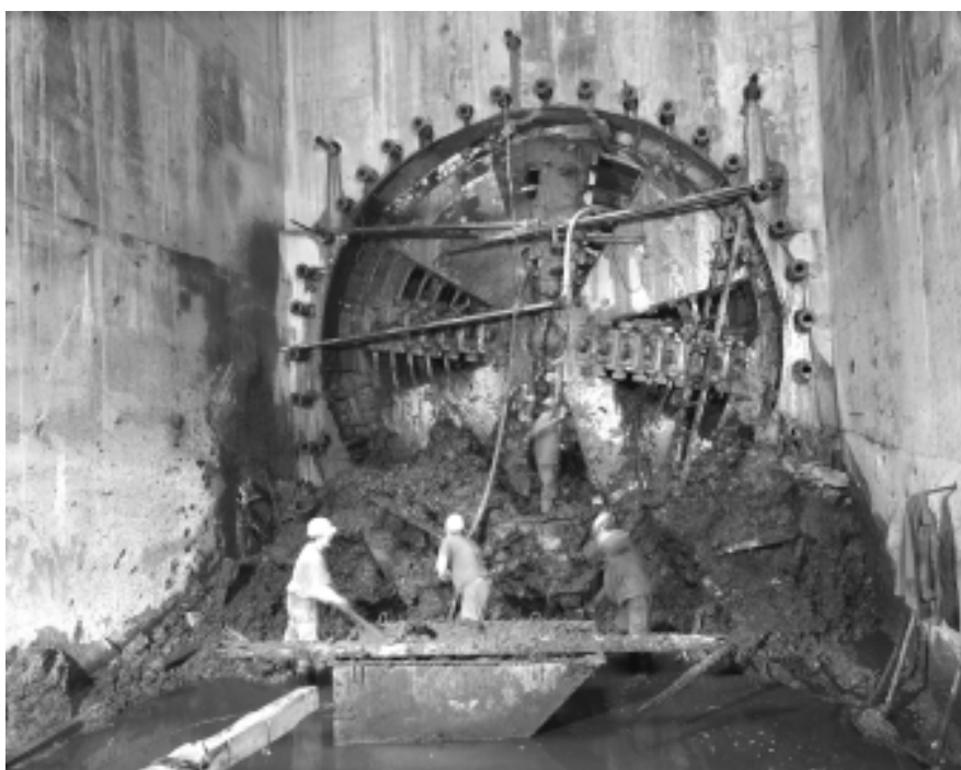
Ротор ТПК «Ловат» вышел в демонтажную камеру.
