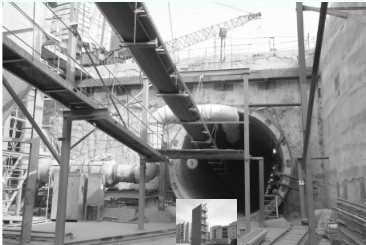
Конвейер уходит в тоннель. Накопительная башня.
