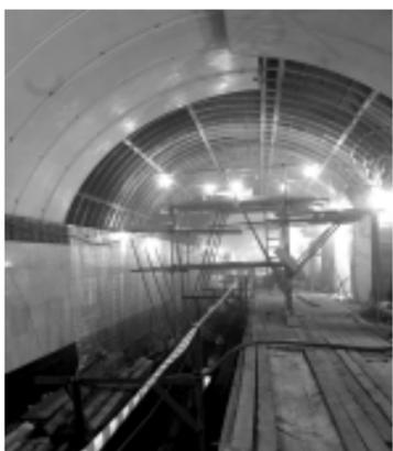
Благодаря усилиям отделочников участка Николая Рекутина из УСР пусковая станция с каждым днём становится светлее и светлее. Над платформой уже более половины чугунных тубингов свода закрыто стеклопластиковым зонтом. Монтируется он и в боковых тоннелях. А обе путевые стены облицовываются в основном светлым мрамором.
