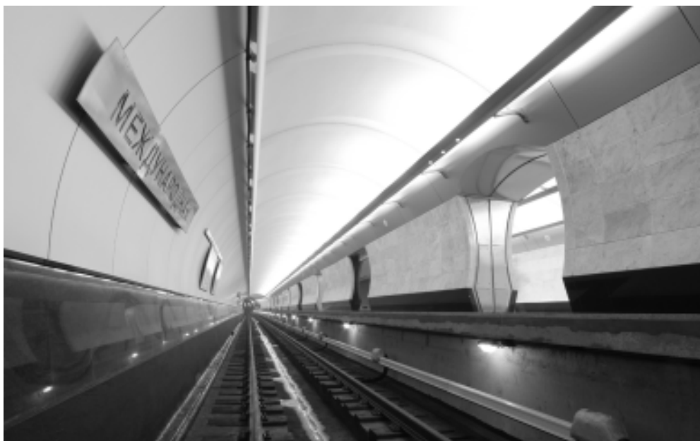
Станция «Международная», отделку которой выполнили специалисты ЗАО «УСР Мосметростроя».
