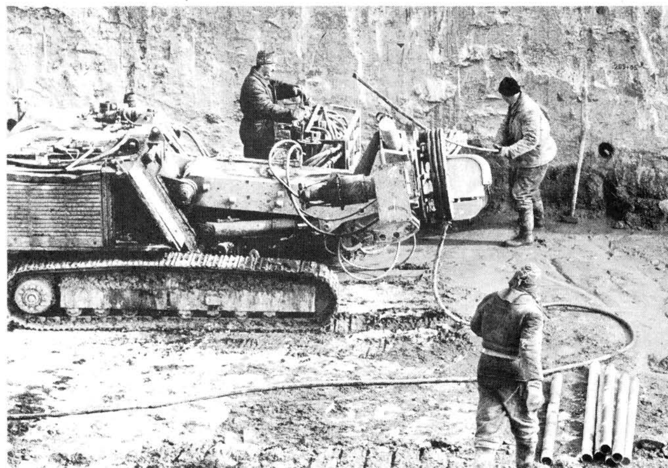
Устройство анкерного крепления на станции «Россошанская».
